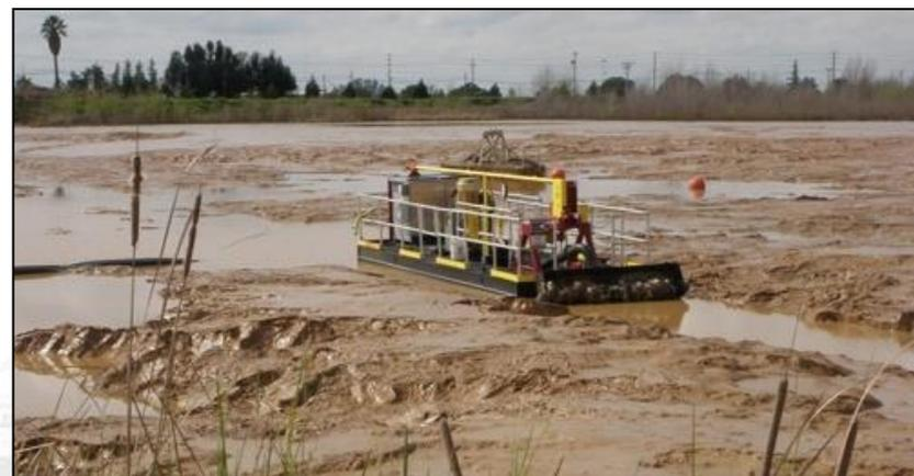
Удаление плотных осадков с помощью драги "Mud Cat 815".
